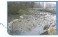
Gestion sélective des embâcles Nettoyage des ouvrages et enlèvement sélectif des arbres et des branches obstruant le lit de la rivière, avec récupération des déchets flottants.
