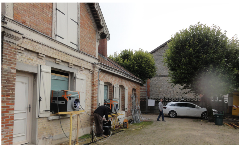
• Désamiantage des locaux
